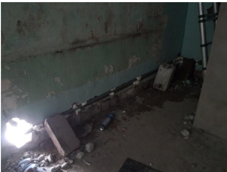
Nieuwe afvoer leiding
