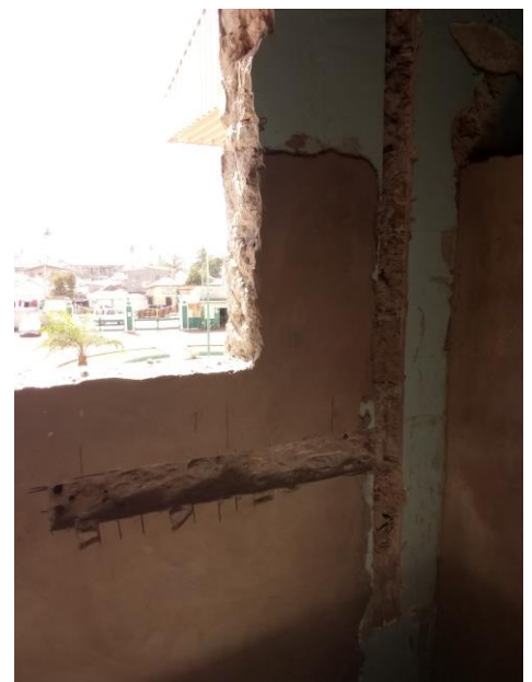
Sleuven voor het leidingwerk
