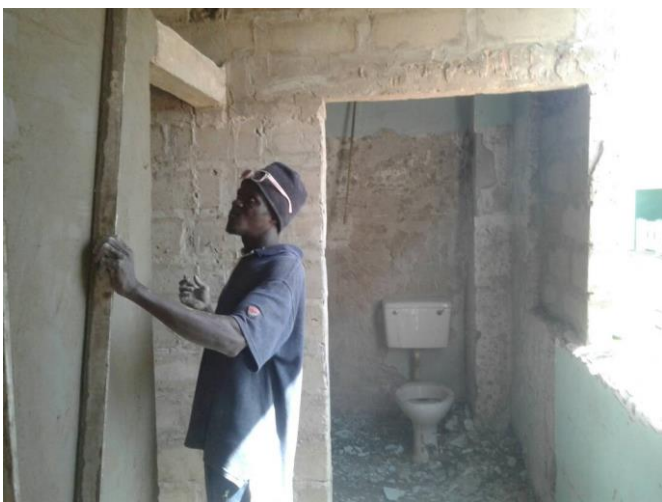
Pleisterwerk wordt aangebracht in corridor/store
