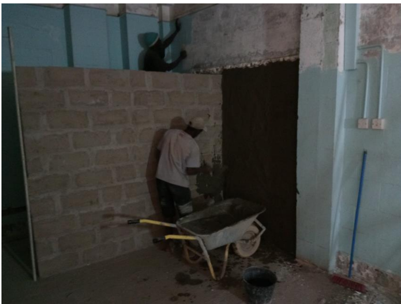
Pleisteren van afscheidingswand ruimte voor reinigen instrumenten
