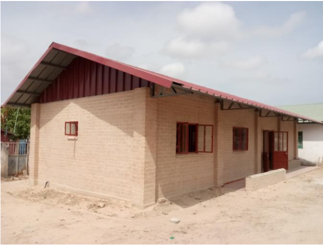
Metselwerk schoon gemaakt en klaar voor de water afstotende finishing
