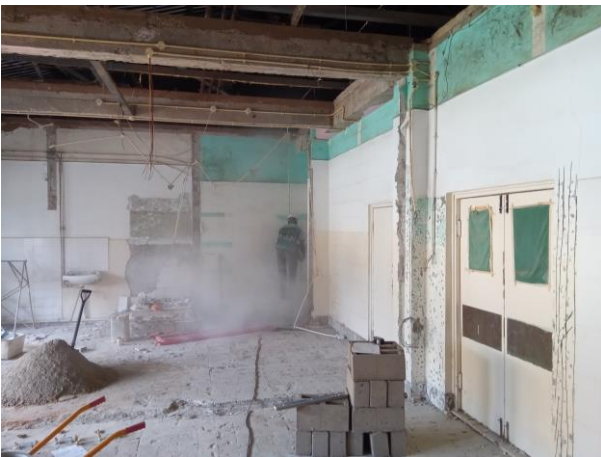
Sleuven zagen voor de waterleidingen
