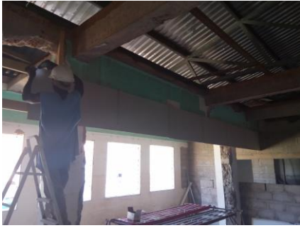
Gipsplaten aanbrengen
