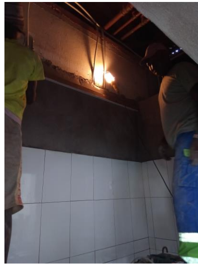
Hoeklijn montage voor het plafond
