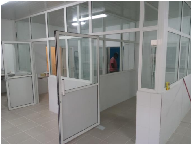
Toegangsdeur van de sluis
