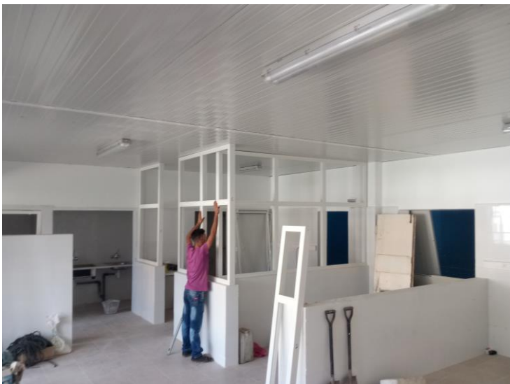
Assembleren van de kozijnen
