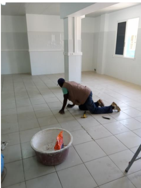
Vorbereiding vloer voegwerk
