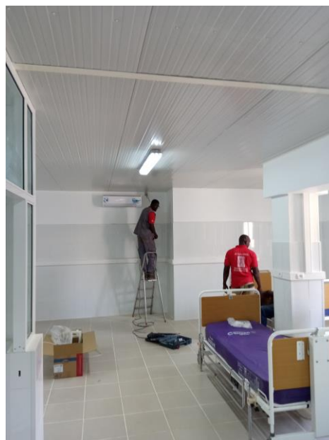
Montage van de airco
