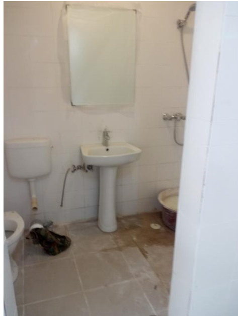
Specie voor vloertegelwerk aanbrengen Badkamer sanitair wordt gemonteerd
