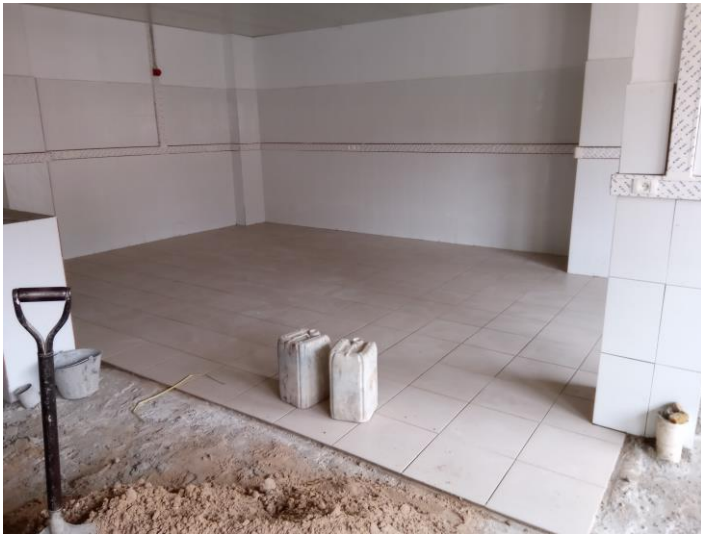
Vloertegelwerk grote zaal
