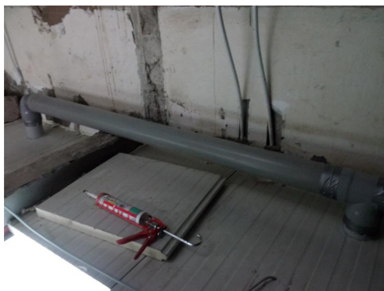
Mechanische afzuiging van de natte ruimtes van boven en
