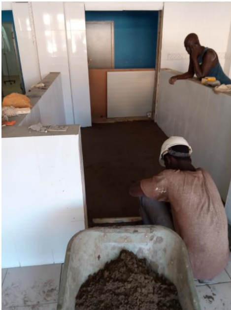
Specie voor vloertegelwerk aanbrengen Badkamer sanitair wordt gemonteerd
