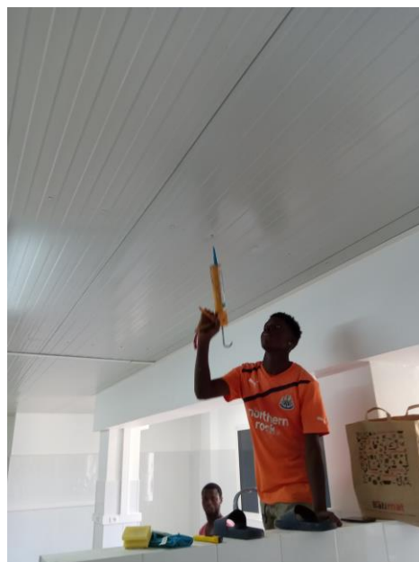
Laatste plafond afwerking
