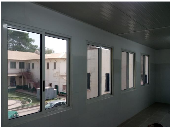
Ramen in de buitengevel
