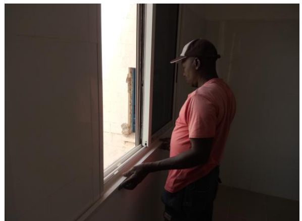
Montage van afwerking rond de ramen
