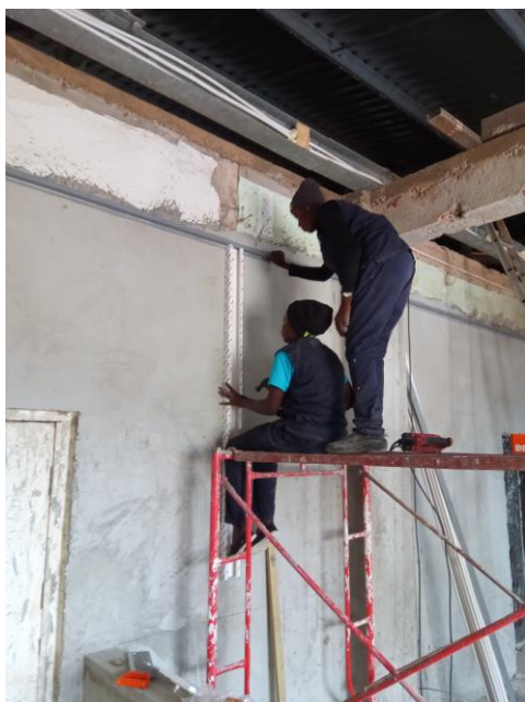
Aanbrengen van de elektra goten
