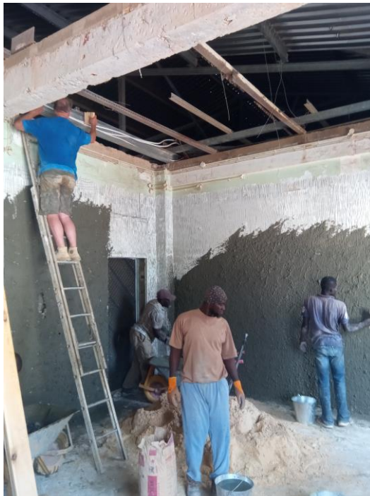
Nieuw pleisterwerk wordt aangebracht
