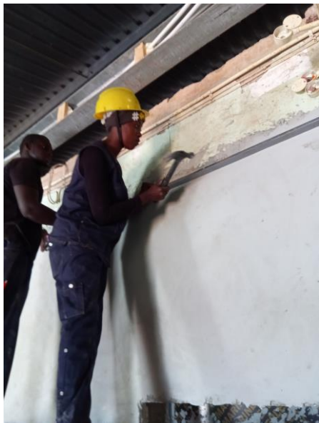
Het aanbrengen van de hoeklijnen waarop de geïsoleerde plafondplaten rusten
