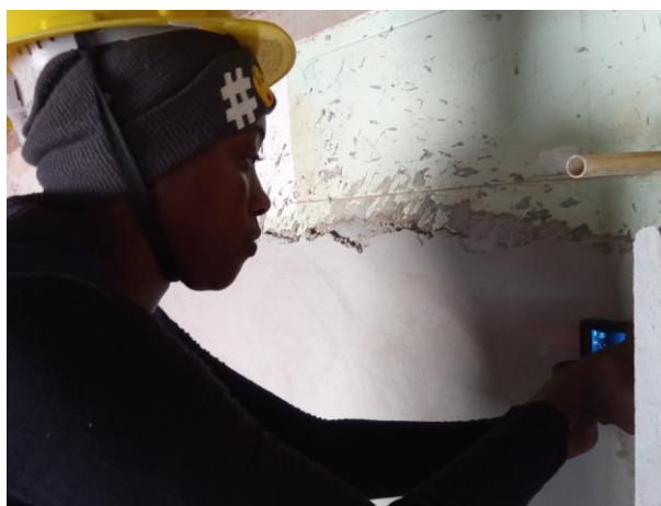
Metten voor plafond montage
