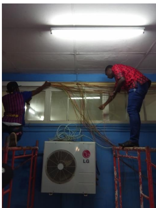
Overbodige bedrading wordt verwijderd
