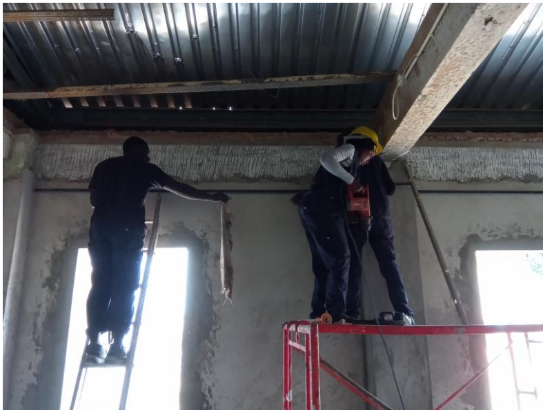
Het aanbrengen van de hoeklijnen waarop de geïsoleerde plafondplaten rusten
