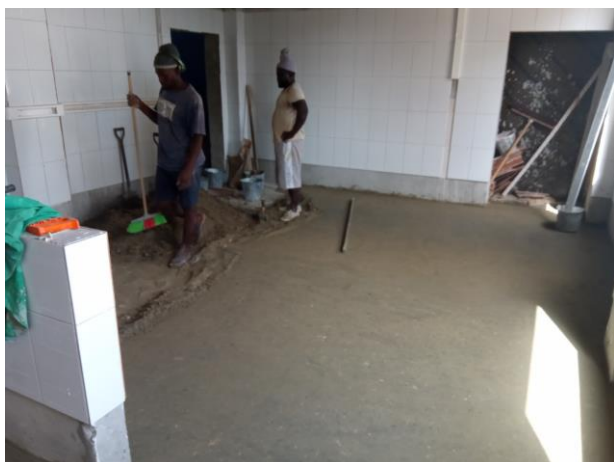
Het laatste stukje van de vloer wordt glad getrokken
