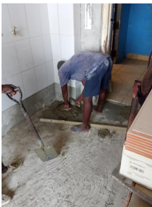
Uitzetten van hoogte voor de afwerkvloer
