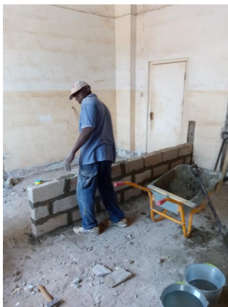
Scheidingsmuur tussen operatiekamer en scrub word gemaakt
