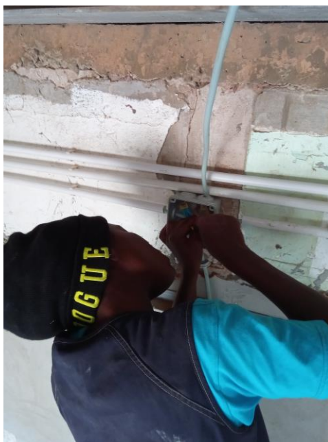
Aansluiten van de bekabeling boven het plafond
