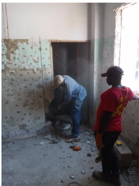
Deur opening wordt vergroot
