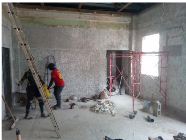
De muren zijn "ruw" gemaakt voor het nieuwe pleisterwerk
