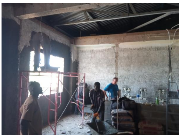
Pleisterwerk rond de kozijnen
