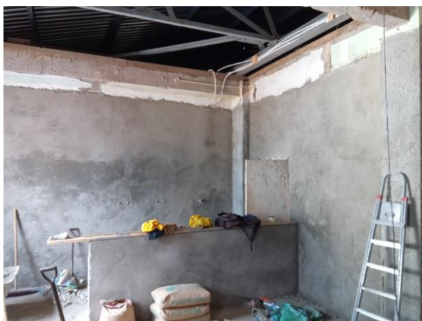
Pleisterwerk is klaar
