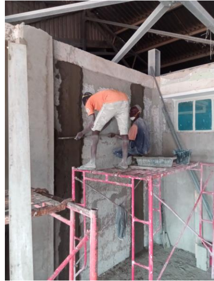
Aanbrengen pleisterwerk
