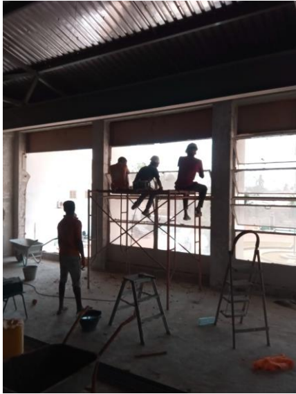
Verwijderen voorgevelkozijnen
