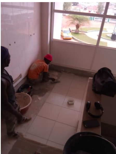
Vloertegelwerk aanbrengen
