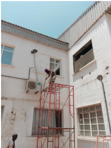
Herstel gat doorvoer airco small theatre (fase 3) buiten- en binnenzijde
