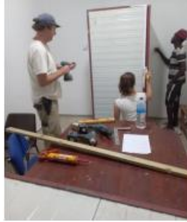
plaatsen van een blinde wand
